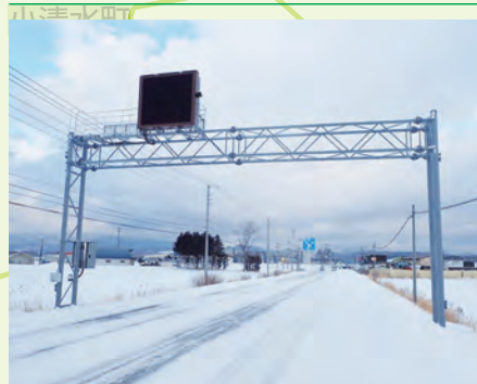
■ 令和元年度施工 国道244号以久科情報板
