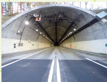
■ 令和2年度施工 国道333号旭野トンネル照明
