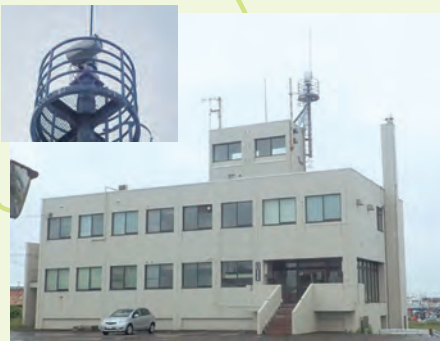
■ 令和2年度施工 紋別港湾事務所CCTV
