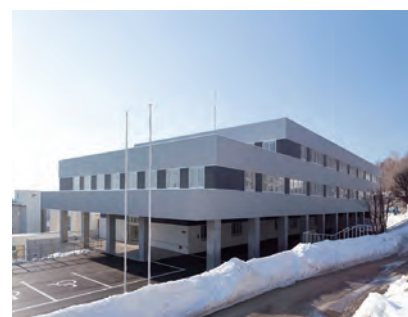
■ 平成28年度施工 網走向陽ヶ丘病院通信設備
