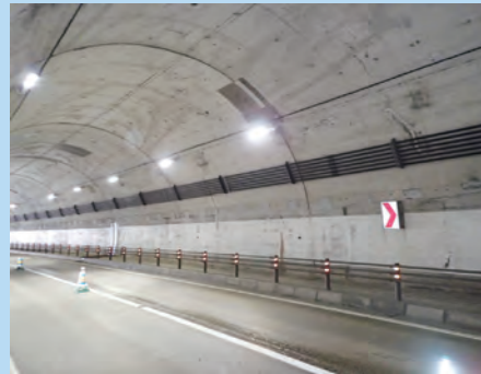
■ 平成29年度施工 国道334号オシンコシントンネル照明
