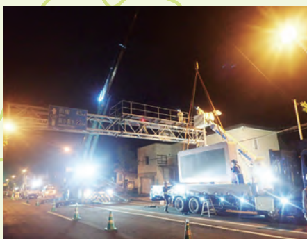
■ 令和2年度施工 国道39号大曲情報板撤去
